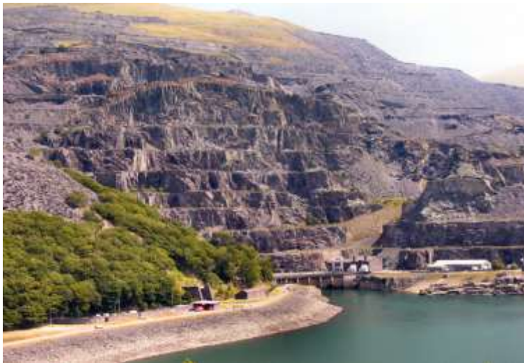
Rys. 10. Elektrownia szczytowo-pompowa Dinorwig w Walii.
