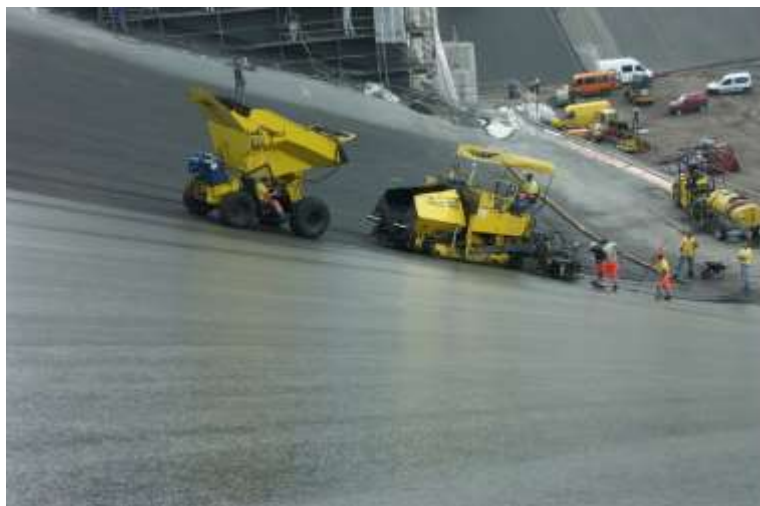
Rys. 3. Wykonanie renowacji ekranu asfaltobetonowego ESP Żarnowiec.
